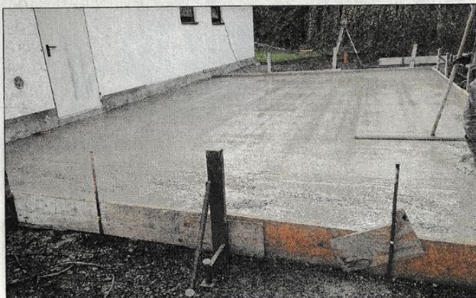
Die „frisch gegossene“ Bodenplatte
