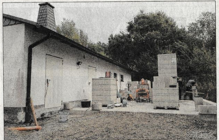
Die Maurerarbeiten haben begonnen
